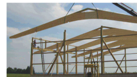
Structure poteau-poutre en lamellé collé.
