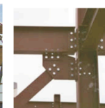
Poutre IPN en acier .
