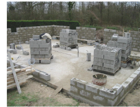
Construction en parpaing.
