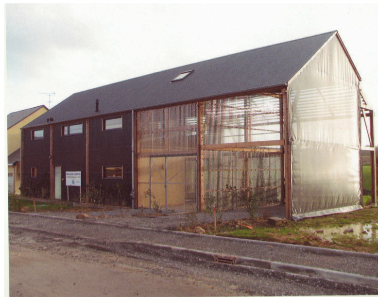
L'angle nord-ouest : tôle ondulée laquée et polycarbonate en façade nord, voile textile opalescent en pignon.
